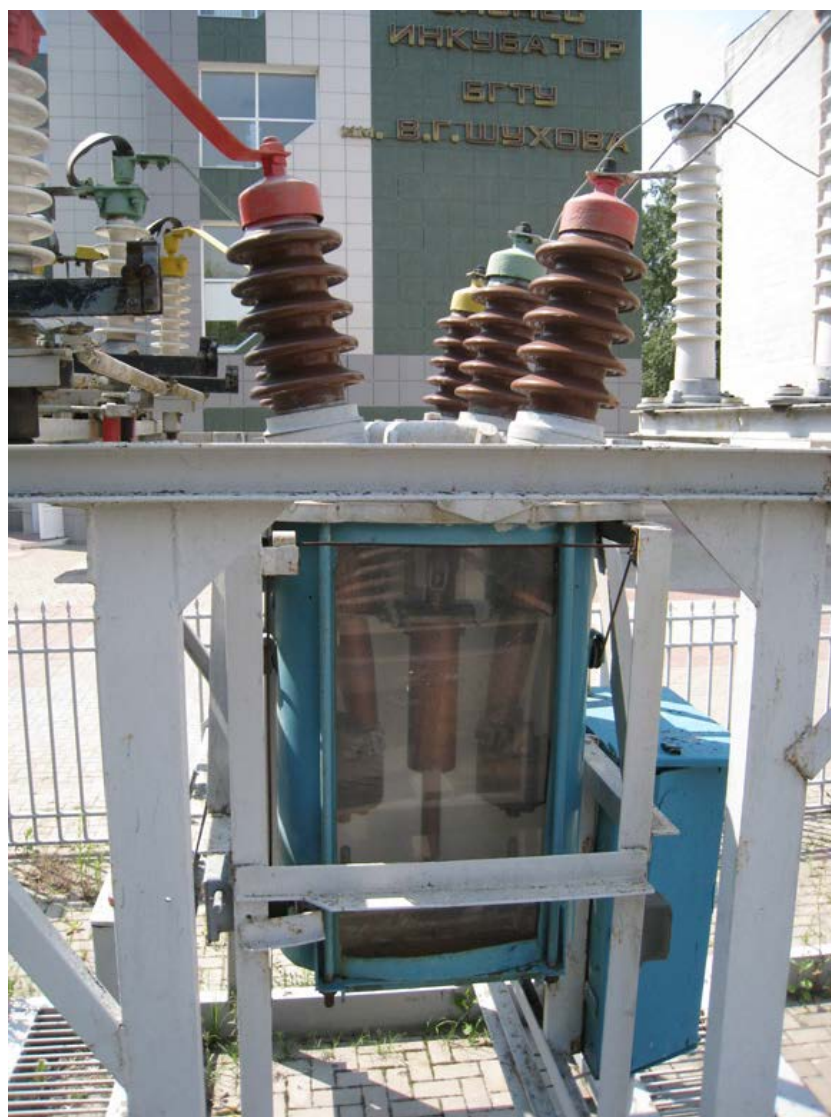
Рис. 5.8. Масляный выключатель ВМ-35 кВ бакового типа
