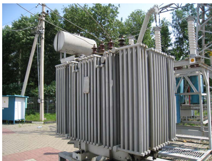
Рис. 5.6. Силовой масляный трансформатор FTDO 1250/35 мощностью 1250 кВА
