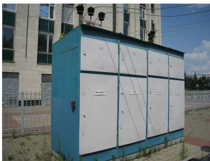
Рис. 5.7. Ячейки КРУН – 10 кВ
