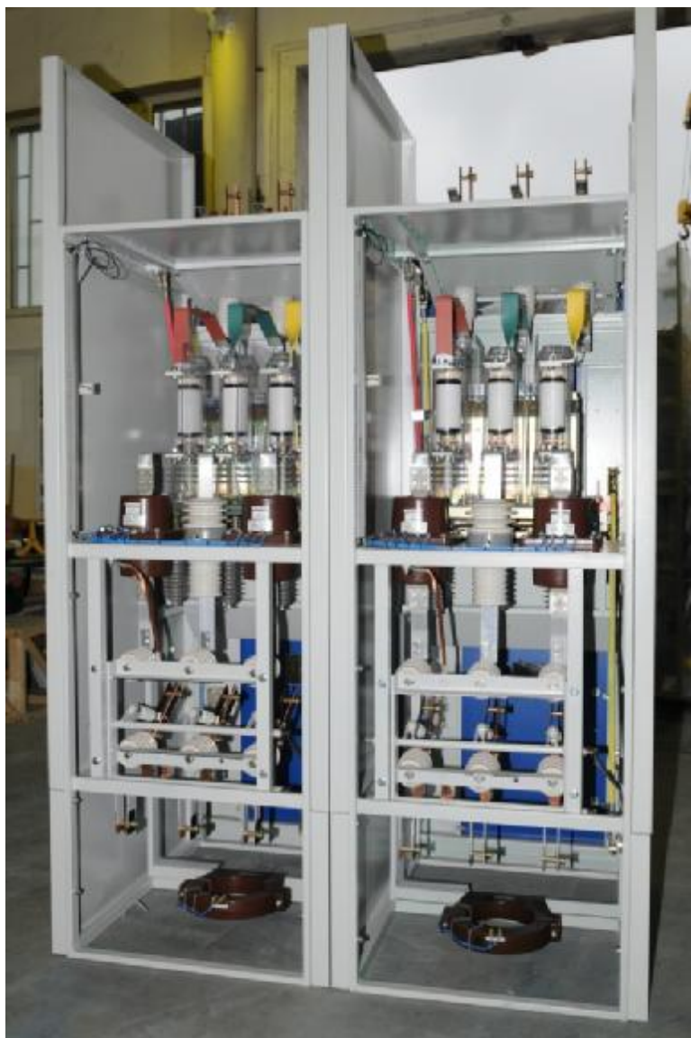
Трансформаторы тока ТПОЛ-10, установленные в фазах А и С камеры КСО
