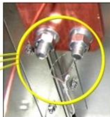
◀ Датчики в линейном отсеке
