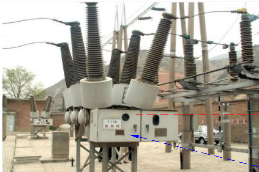
Выключатель на ОРУ 110 кВ
